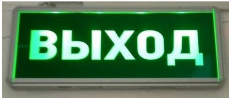
Фото № 13. Визуальные средства путей эвакуации
