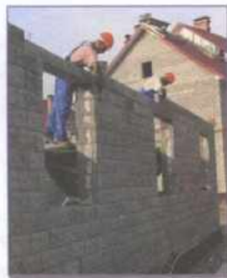
Рис. 26. Выкладка кирпичной стены
